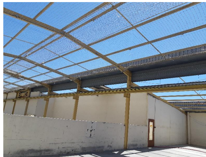
Filet sécurité avant travaux réfection toiture
