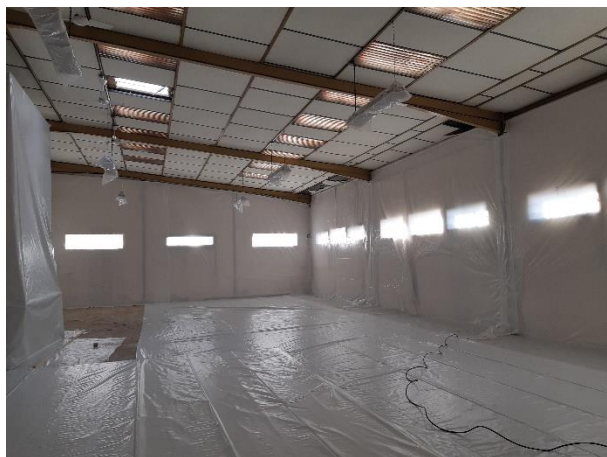
Confinement avant désamiantage
