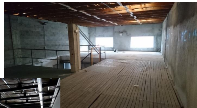
Salle de réunion polyvalente Début des travaux
