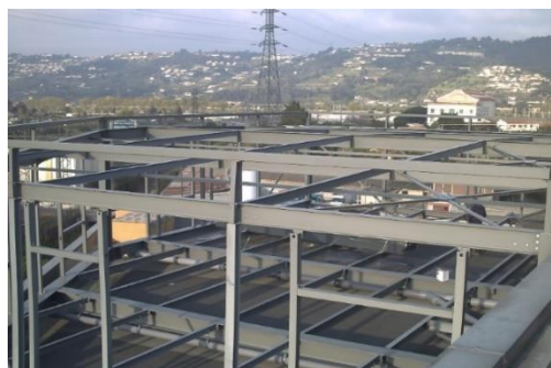
Charpente métallique posée
