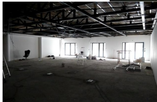
Salle de réunion polyvalente Travaux avancés
