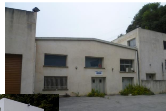
Bâtiment 2 - Avant travaux
