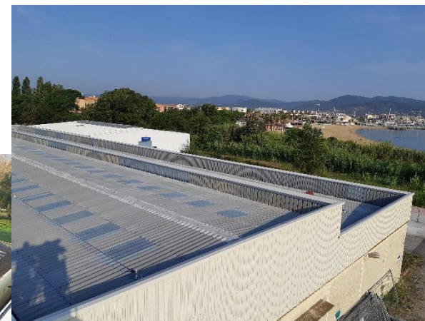
Toiture avant et après travaux
