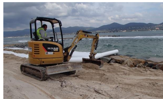
Plage de la Bouillabaisse Travaux phase 2 - mars 2014
