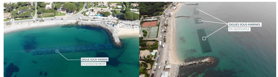
Aménagement des digues sous-marines
