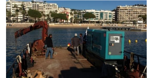
Pose d'une rangée supplémentaire de géotubes
