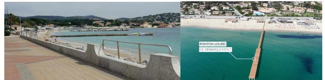
Reprise et création de pontons d'accès
