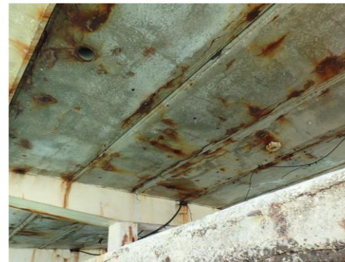
Ponton Carlton : dalles béton fissurées (01-2018)
