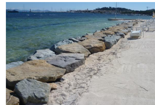
Plage de la Bouillabaisse Travaux phase 1 - mai 2013
