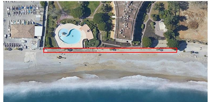
Linéaire de platelage impacté par la tempête du 23 novembre 2019
