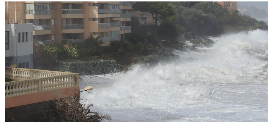
Brèche dans le mur de protection vue depuis le port de Toga Tempête Adrian 2018 - Copropriété I Minelli octobre 2018
