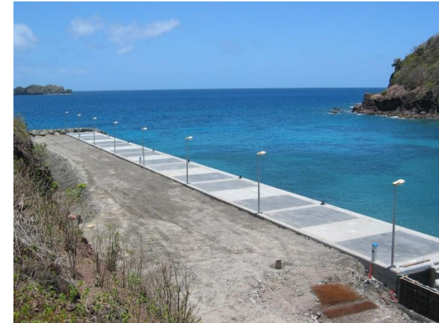
Réalisation du ponton (navettes passagers 30 m)
