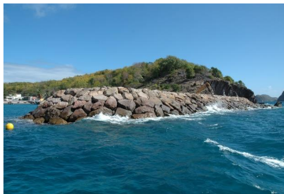
Protection maritime côté mer
