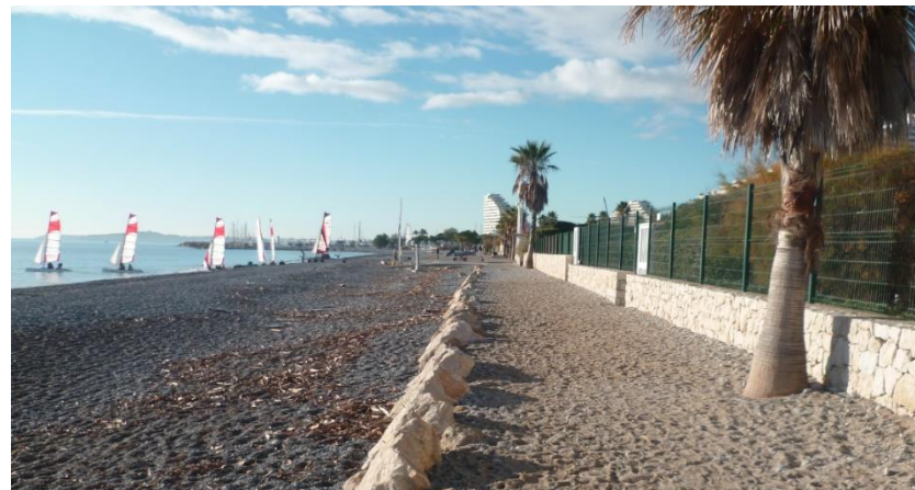
Haut de plage concerné par la reprise du platelage (ICTP 9 décembre 2020)
