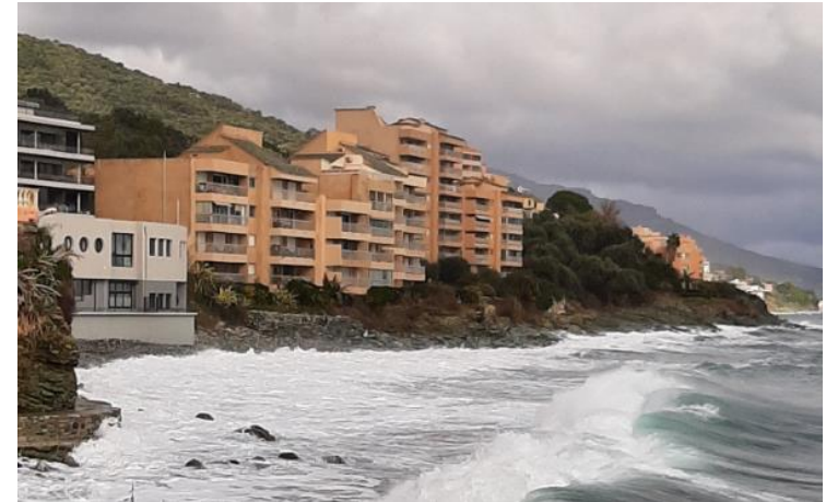
Brèche dans le mur de protection vue depuis le port de Toga Tempête Adrian 2018 - Copropriété I Minelli octobre 2018
