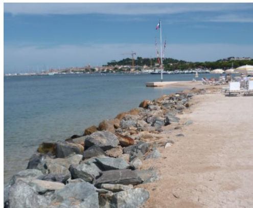
Plage de la Bouillabaisse Avant travaux – septembre 2011
