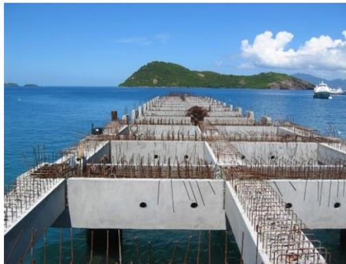
Ossature béton armé fondée sur pieux
