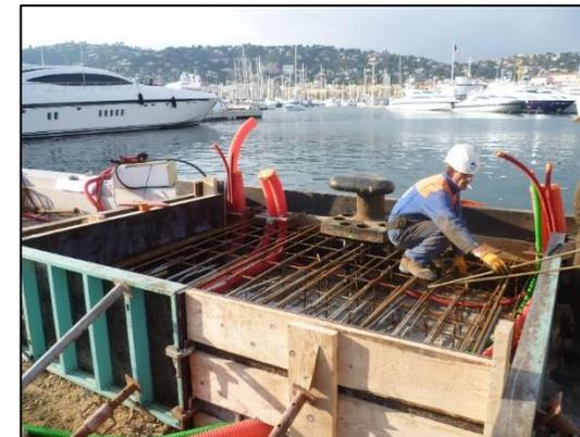
Ferraillage de rehausse des bollards
