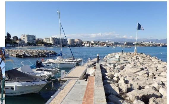
Ponton fixe sur appuis et ponton flottant
