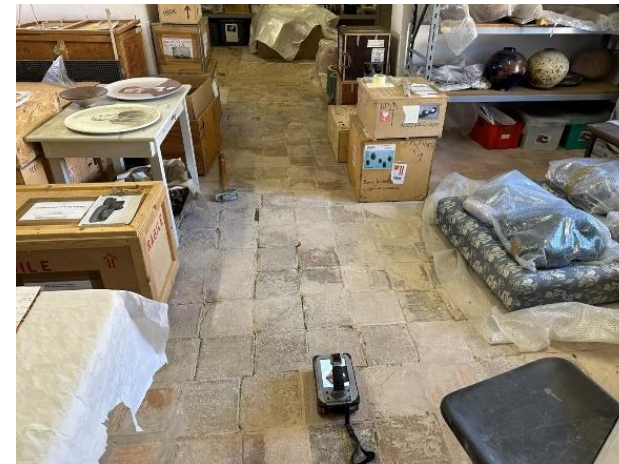
Passage radar au niveau du sol
