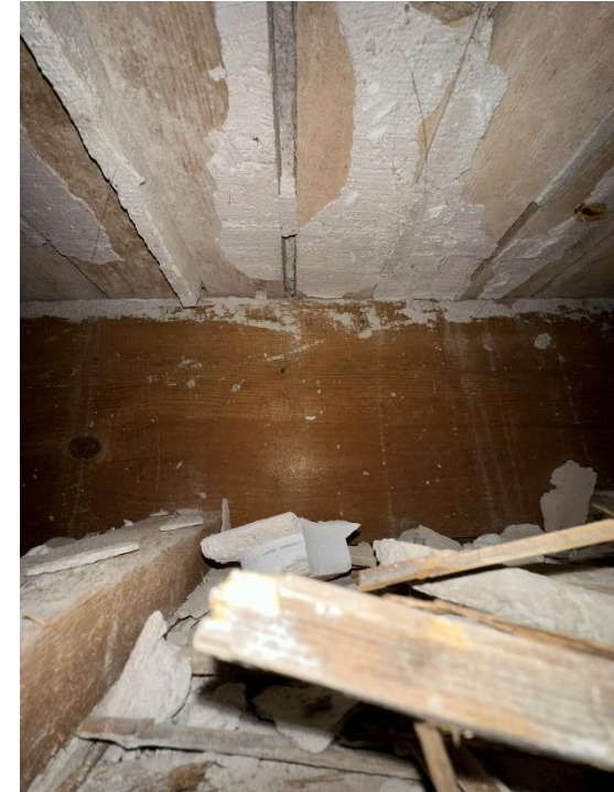
Sondage destructif plancher
