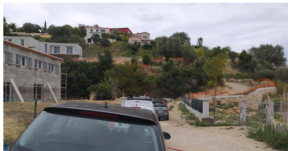
Avancement du chantier – octobre
