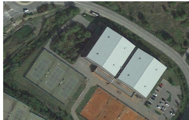
Ouvrage de traitement et de rétention réalisé en 2015 Google Earth 2022
