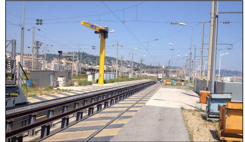
Zone de nettoyage externe avant travaux (RAZEL BEC - 2015)
