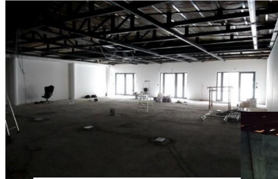
Salle de réunion polyvalente Début des travaux
