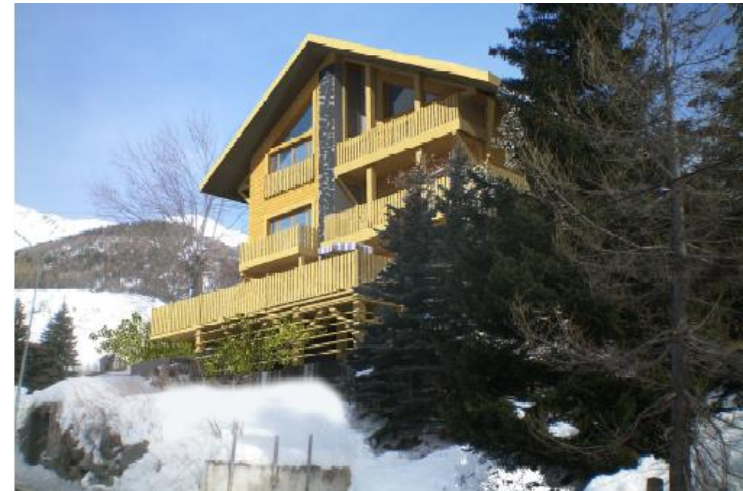
Appartements La Bartavelle après travaux (DP, Août 2019)
