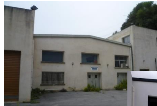
Bâtiment 2 - Avant travaux
