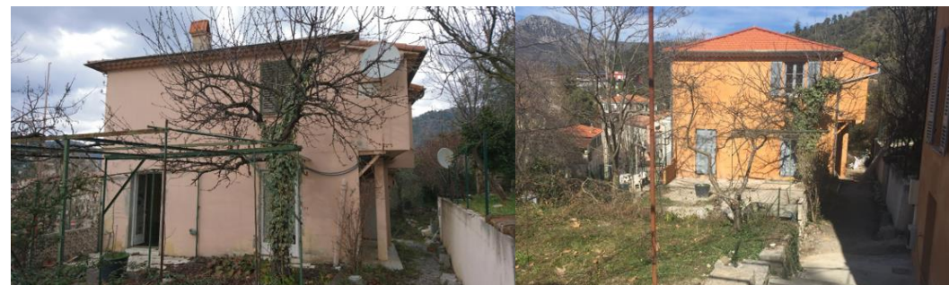
Villa 225 Façade sud – Avant travaux en 2017 et après travaux en Mars 2019
