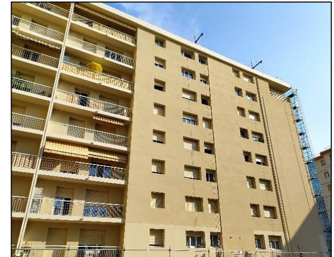
Travaux ITE en cours de réalisation
