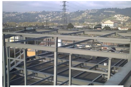
Charpente métallique posée
