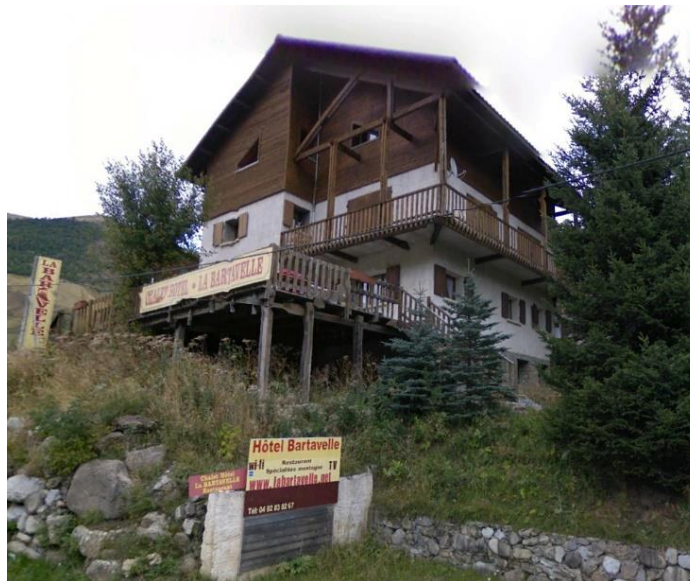
Hôtel La Bartavelle avant travaux (Google Earth Street View 2008)
