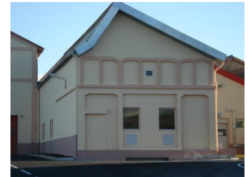
DCNS local SYP Vue extérieure - Etat final
