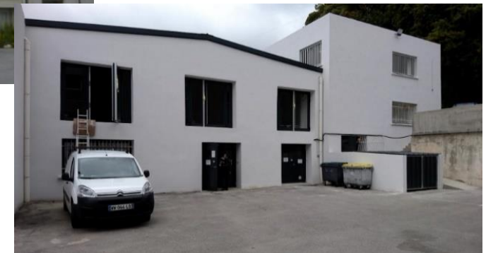
Bâtiment 2 - Après travaux
