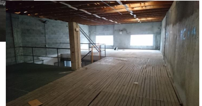
Salle de réunion polyvalente Travaux avancés
