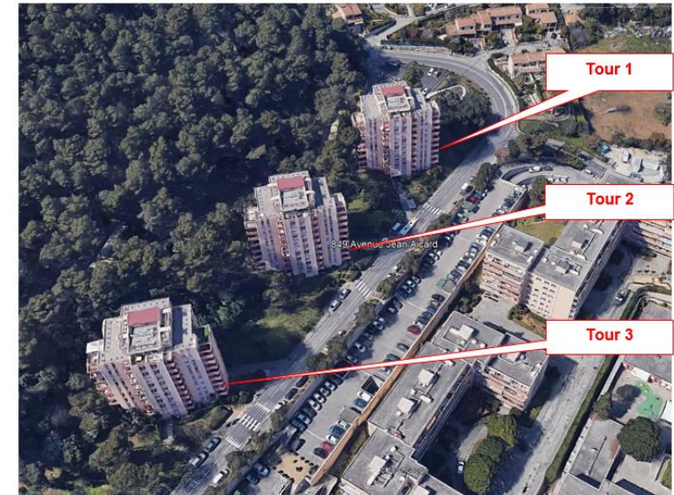
Résidence Les Pugets au 849 avenue Jean Aicard composée de 3 tours
