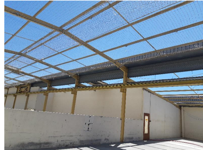
Filet sécurité avant travaux réfection toiture
