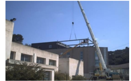
Pose de la charpente métallique par grue élévatrice pour extension bâtiment
