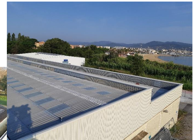
Toiture avant et après travaux
