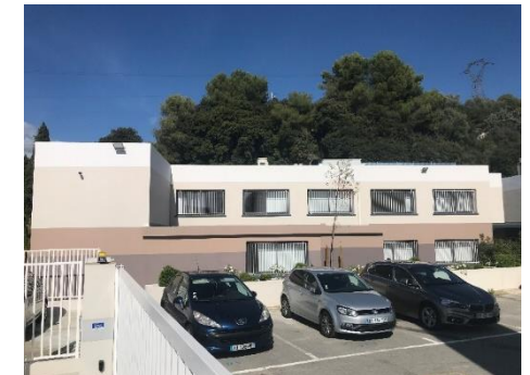
Bâtiment réhabilité sans extension
