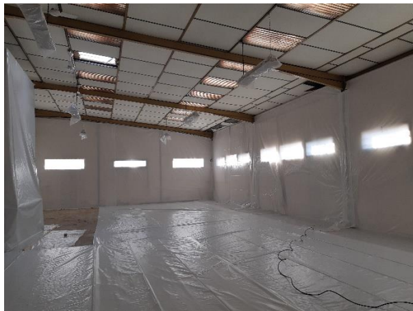
Confinement avant désamiantage
