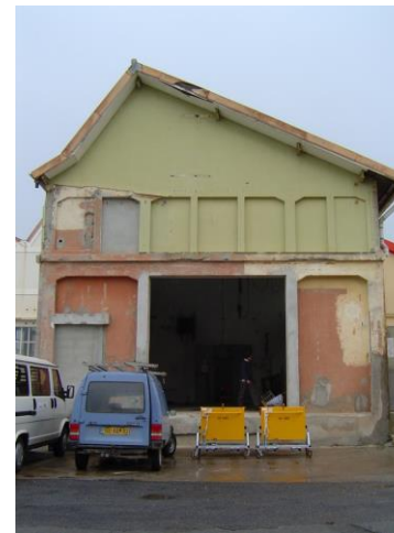
Naval Group local SYP Vue extérieure pendant les travaux
