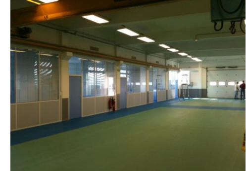
Naval Group local atelier + bureaux Après réfection
