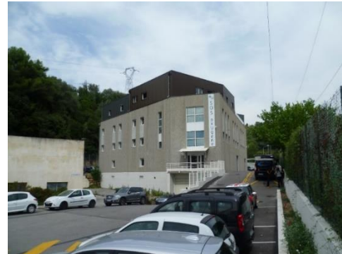
Extension finalisée avec enseigne posée
