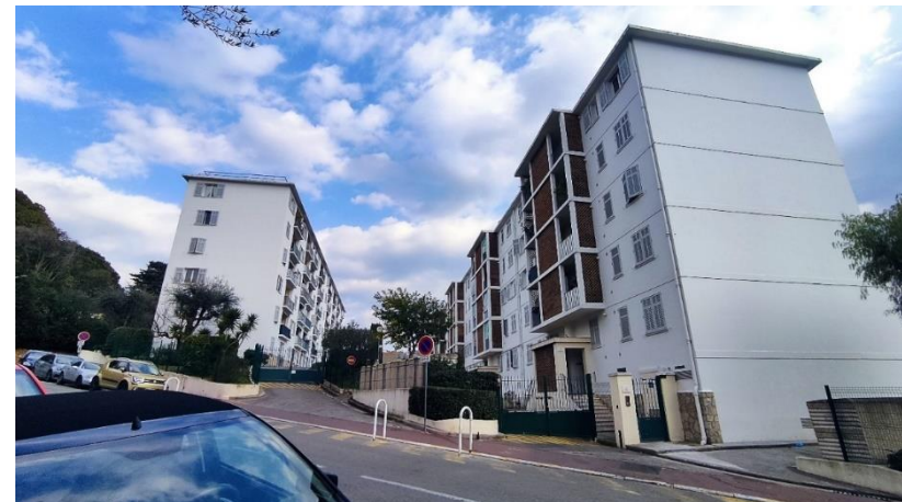
Les 2 bâtiments de la résidence « Le BRET » au 48-50 Avenue du Commandant Bret à Cannes.
