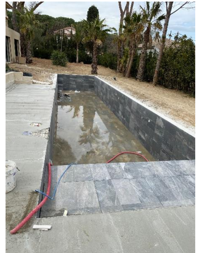
Piscine en cours de travaux
