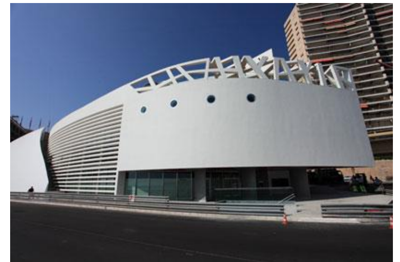
Façade architectonique – Etat final
