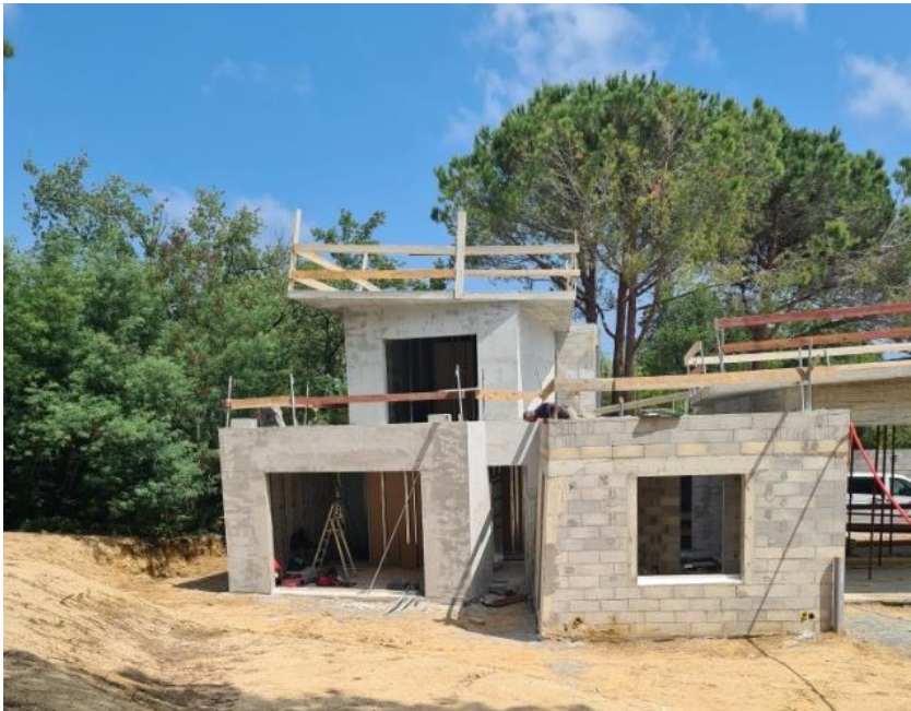
Villa en cours de travaux – chambres et cuisine
