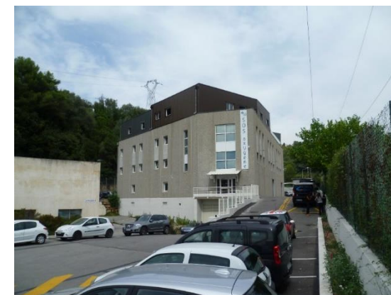
Extension finalisée avec enseigne posée
