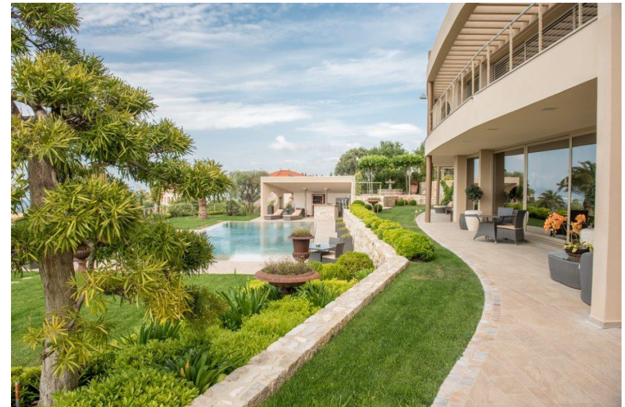
Vue générale - État final
