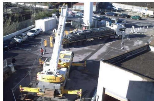
Préparation pour la pose de la charpente métallique
