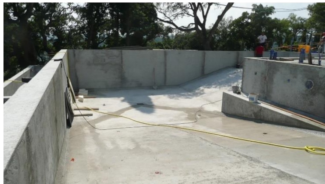
Structure béton armé piscine
