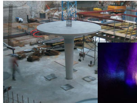
Poteau en cours de réalisation
