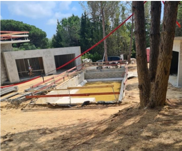
Piscine en cours de travaux
