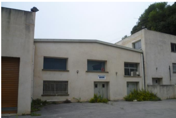
Bâtiment 2 - Avant travaux
