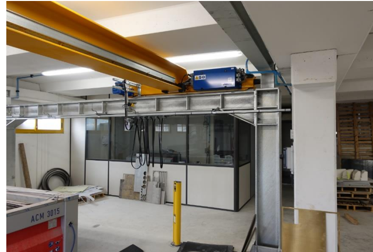
Détail de la structure métallique
