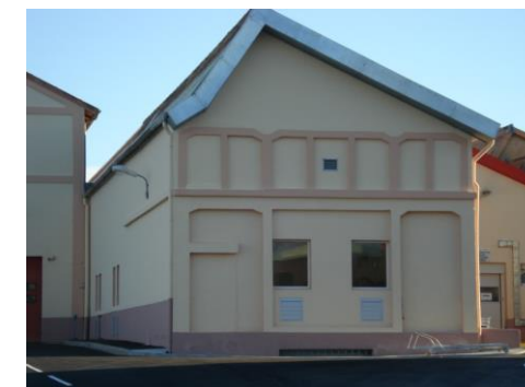
DCNS local SYP Vue extérieure - Etat final
