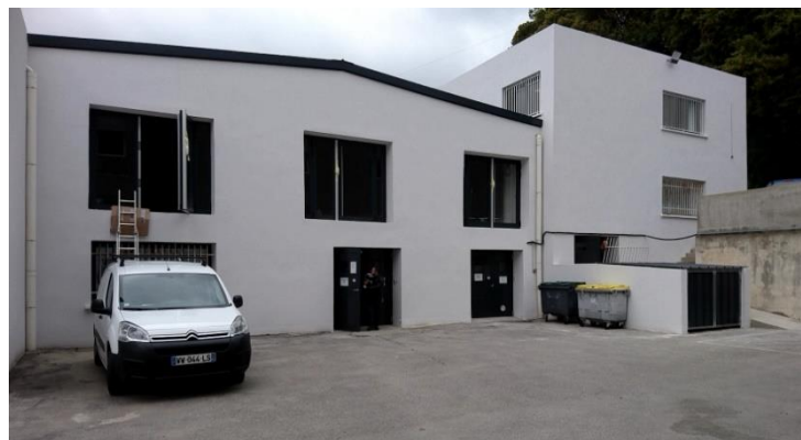
Bâtiment 2 - Après travaux
