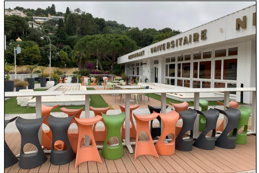
Terrasse à l'état existant
