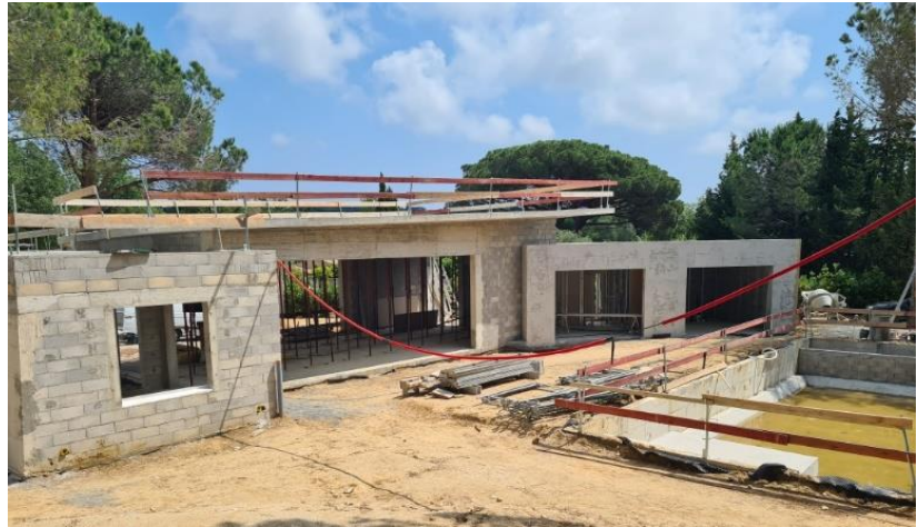
Villa en cours de travaux – chambres et salon
