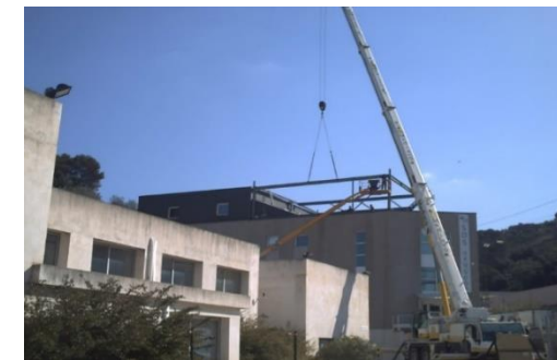
Pose de la charpente métallique par grue élévatrice
