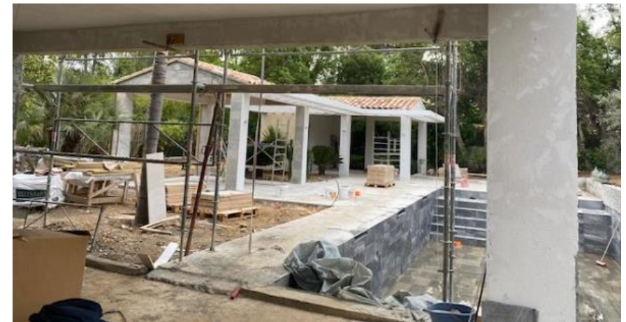
Pool house et piscine
