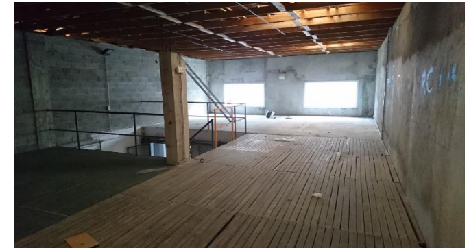
Salle de réunion polyvalente Début des travaux
