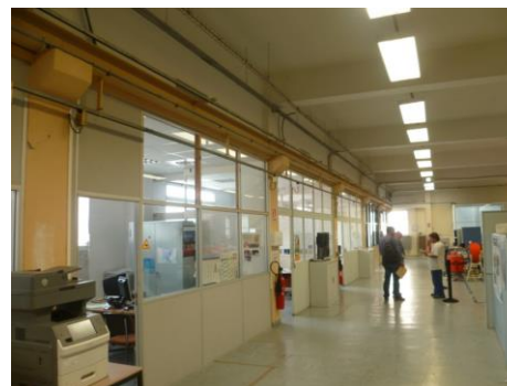
Naval Group local atelier + bureaux Avant réfection
