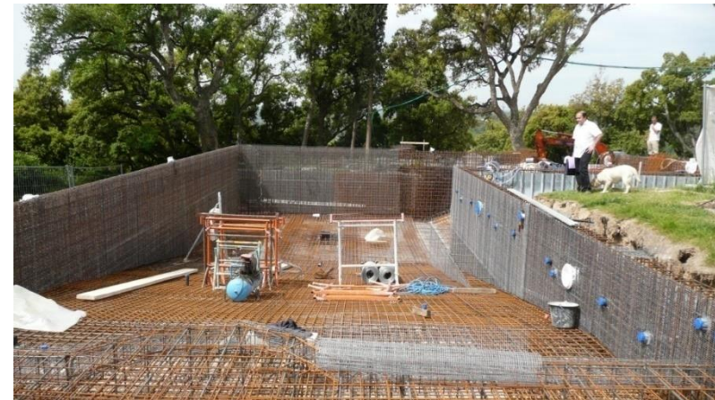
Ferrailage : vue d'ensemble
