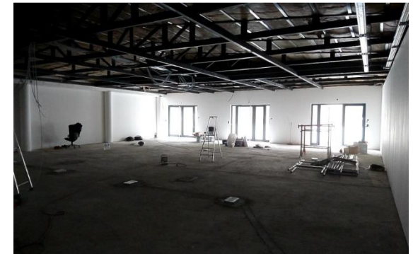
Salle de réunion polyvalente Travaux avancés
