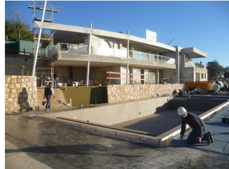
Gros œuvre en cours de réalisation
