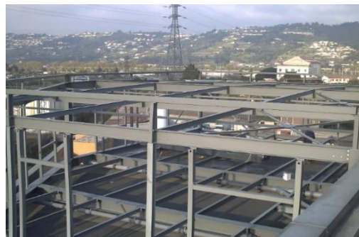
Charpente métallique posée
