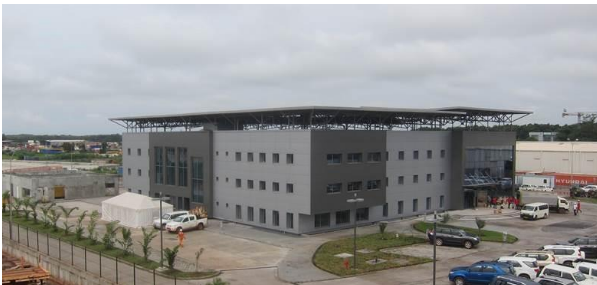
Vue générale bâtiment – revêtements zone sud-est
