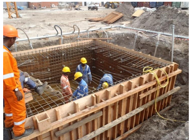
Bassin de récupération des eaux pluviales
