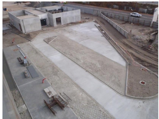
Parkings et voirie Dallage béton fibré et pavage zone ouest
