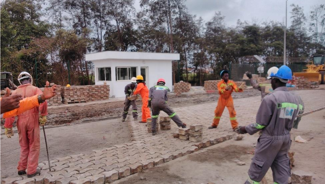
Pavage – pose pavés Trief
