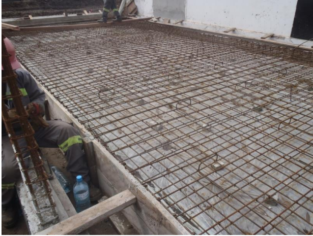
Radier – armatures et coffrages
