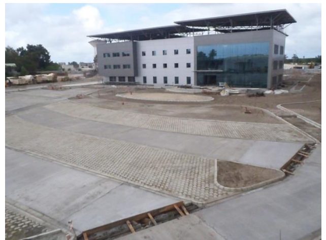
Revêtements – dallage béton fibré et pavage
