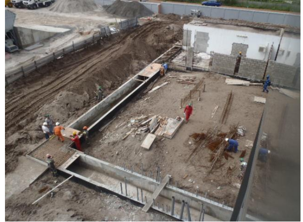
Dalot technique – dalles préfabriquées
