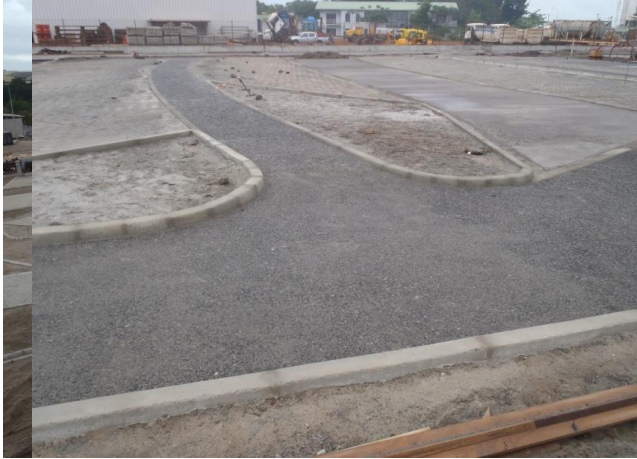
Trottoirs – revêtement béton désactivé
