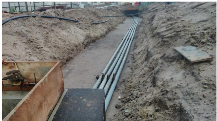
Réseaux secs - fourreaux
