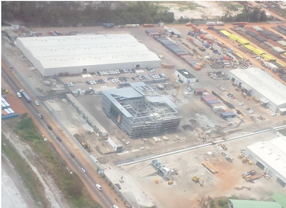
VRD - Vue générale du chantier
