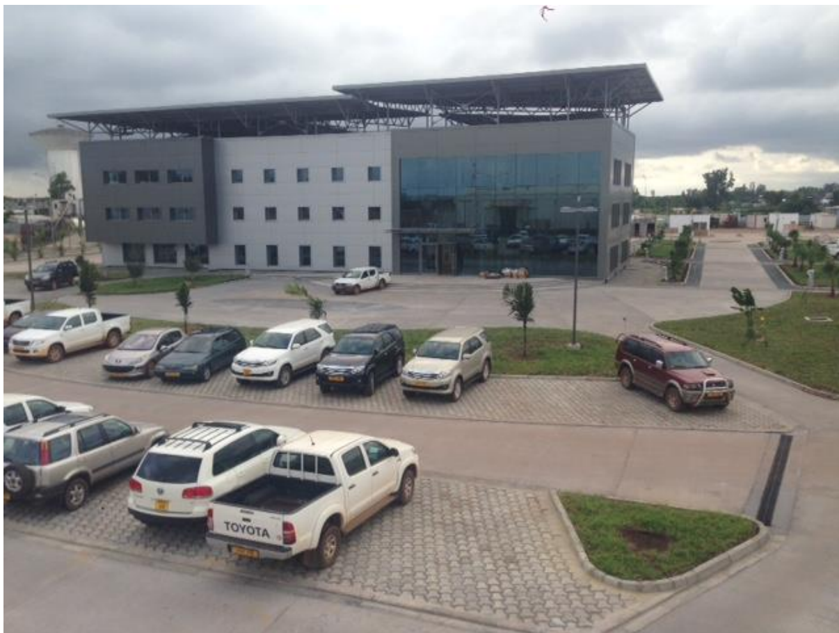
Vue générale bâtiment – revêtements zone nord-est
