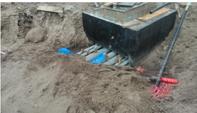
Réseaux secs – fourreaux – pénétration dans regards - calfeutrement
