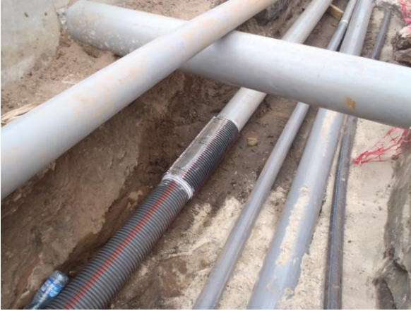
Réseaux secs – croisement réseau existant
