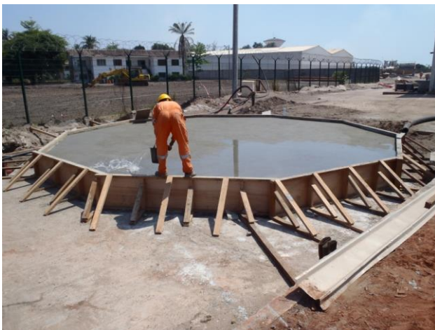
Réseau incendie Dalle sous réserve eau – m.o béton
