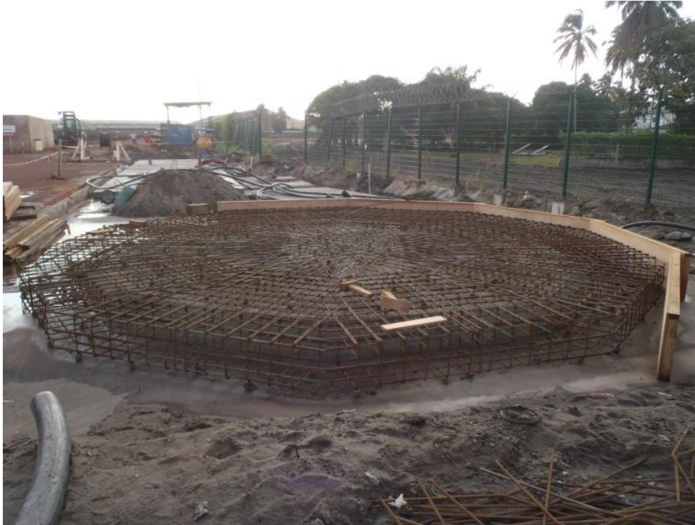
Réseau incendie – dalle sous réserve eau – armatures et coffrages
