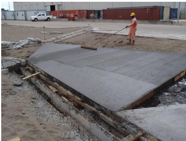
Voirie Dallage béton fibré teinté dans la masse - balayage
