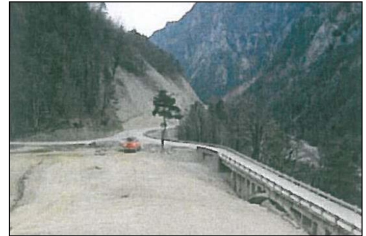
Vue d'ensemble (déblais / remblais)
