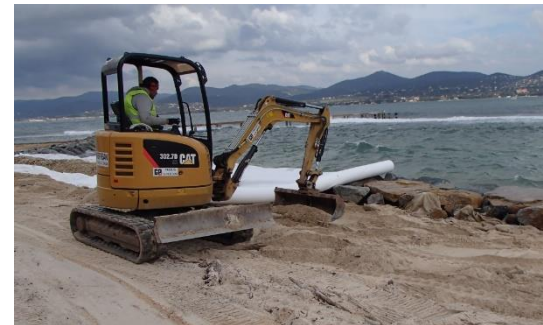
Plage de la Bouillabaisse Travaux phase 2 - mars 2014
