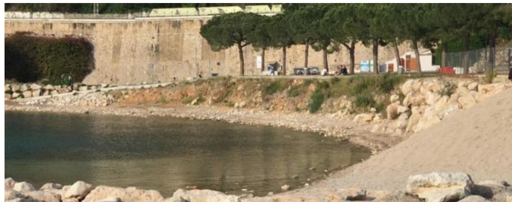
Vestige du perré de protection à l'est Odyssea - 2017
