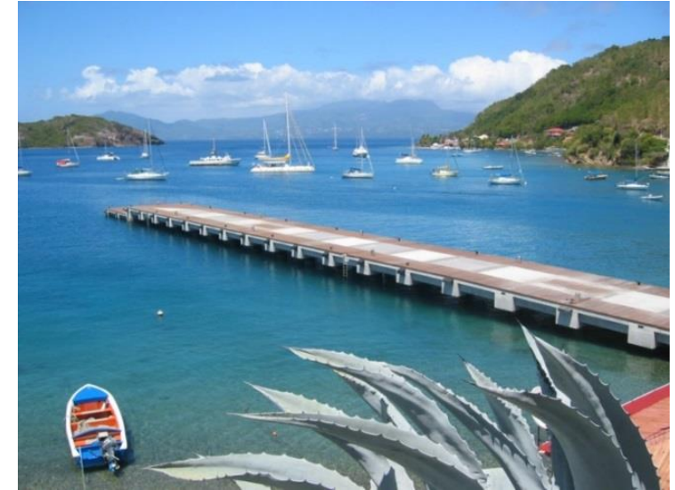
Vue d'ensemble après travaux
