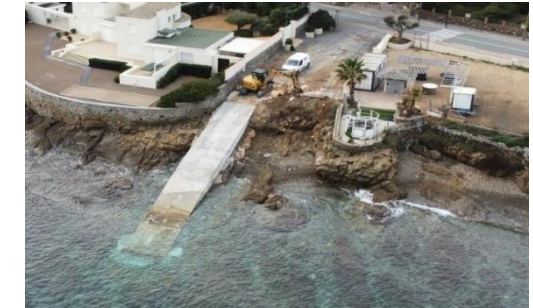
Mise aux normes Cale de mise à l'eau
