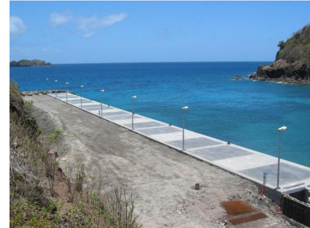
Réalisation du ponton (navettes passagers 30 m)
