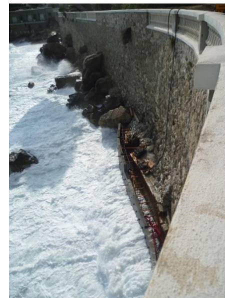
Vue d'ensemble pendant les travaux
