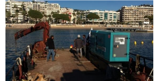
Pose d'une rangée supplémentaire de géotubes
