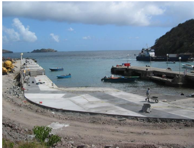
Vue d'ensemble travaux avant démolition de l'ancien appontement
