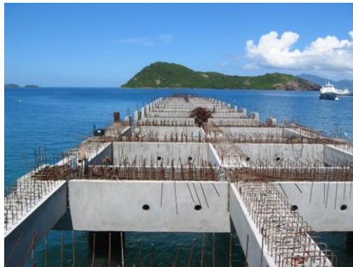
Ossature béton armé fondée sur pieux
