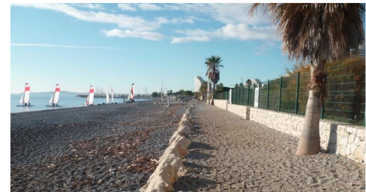
Haut de plage concerné par la reprise du platelage (ICTP 9 décembre 2020)
