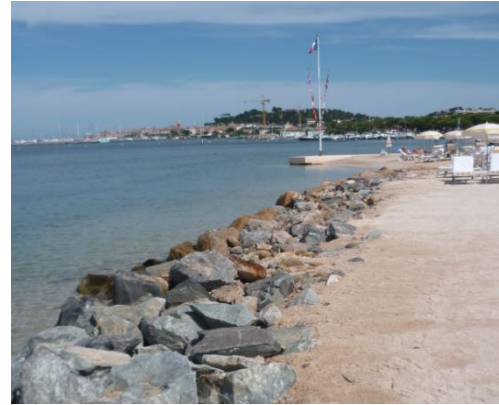
Plage de la Bouillabaisse Avant travaux – septembre 2011
