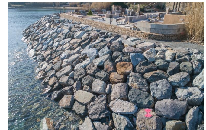
Protection en enrochements réhabilitée – mars 2023
