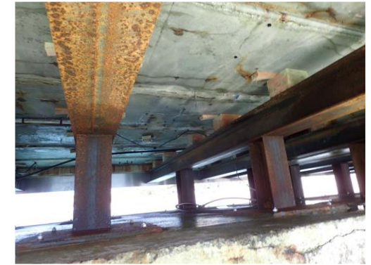
Mise en place de poutres et poteaux métalliques -06-2018
