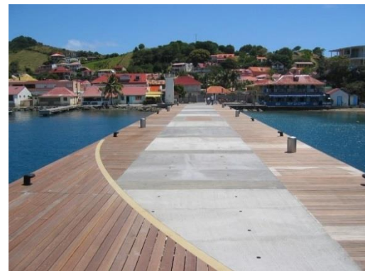
Ponton état final finition mixte bois et béton coloré
