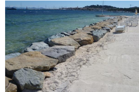
Plage de la Bouillabaisse Travaux phase 1 - mai 2013
