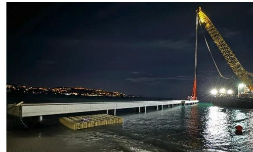
Création ponton d'accès Secteur Croisette - ICTP
