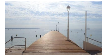
Ponton de Gazagnaire – Réalisé en 2021
