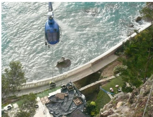
Comblement cavité arrière
