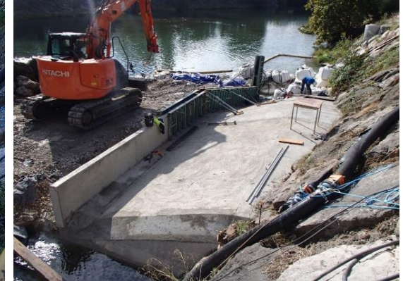
Réalisation passe à anguille (ferrailage/bétonnage) seuil 1 avec batardeau et pompage
