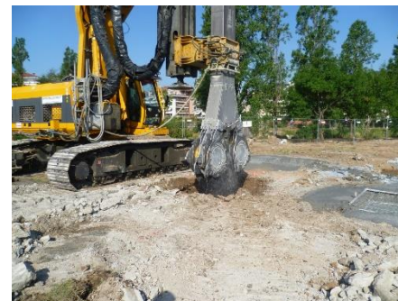
Amélioration du sol par procédé CSM (Cutter Sol Mixing)
