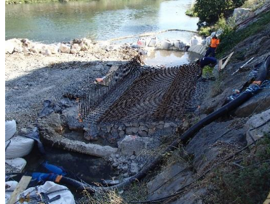
Réalisation passe à anguille (ferrailage/bétonnage) seuil 1 avec batardeau et pompage
