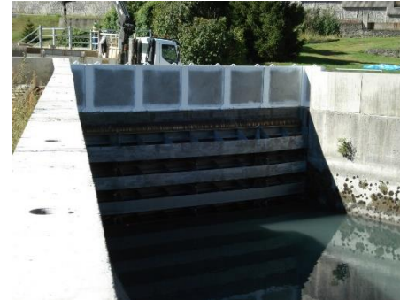
Rehausse exutoire barrage EDF
