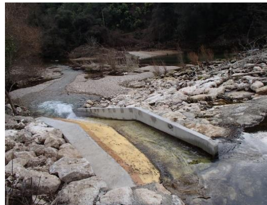
Réalisation passe à anguille (ferrailage/bétonnage) seuil 1 avec batardeau et pompage
