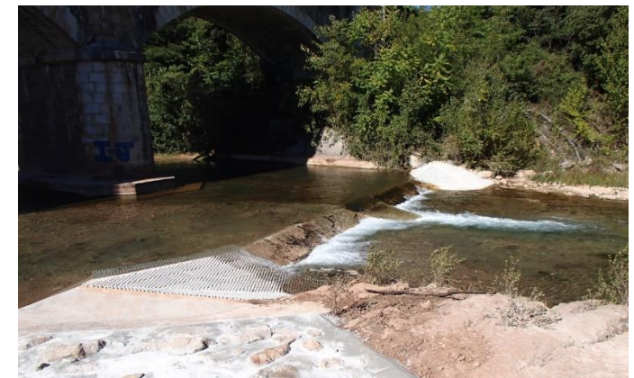
Seuil de Vidauban après travaux (juillet 2016)
