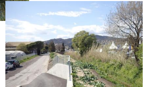
Contre-canal avant et après travaux – ICTP 2011 et 2018
