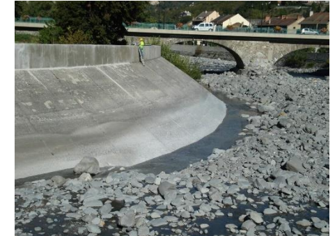
Rehausse exutoire barrage EDF
