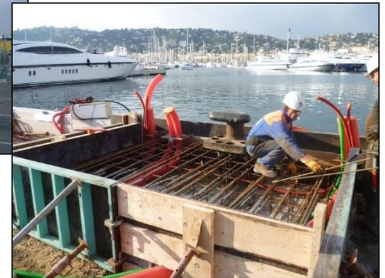
Ferrailage de rehausse des bollards
