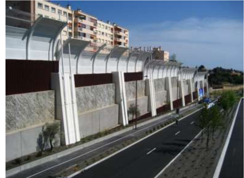
Mur ancré et écrans acoustiques
