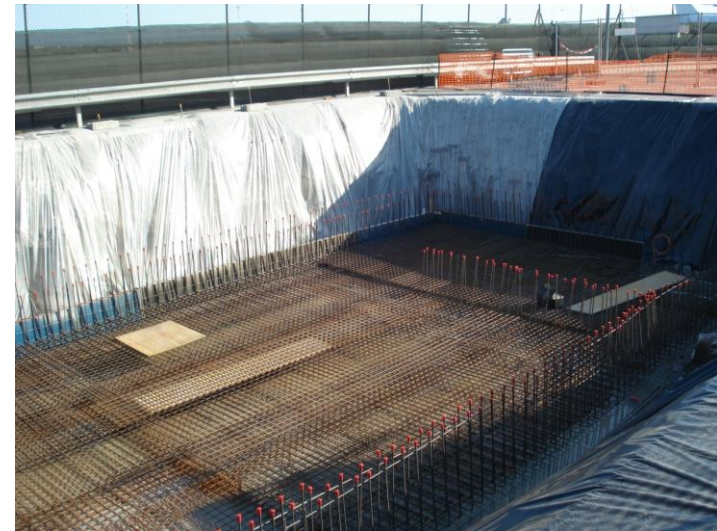
Ferrailage radier bâche tampon n° 1
