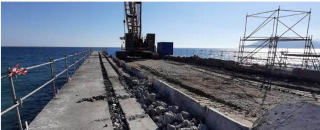
Travaux de désamiantage du ponton Est de la Darse
