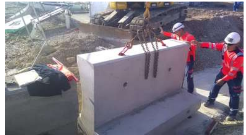
Assemblage des éléments préfabriqués
