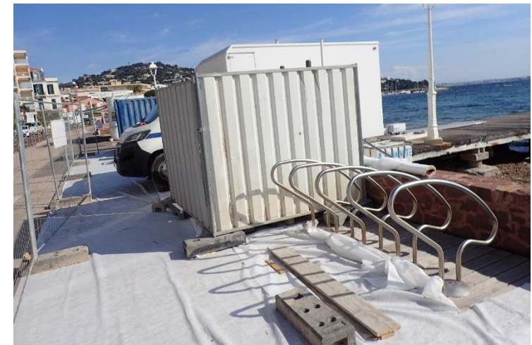
Zone de stockage et camion d'unité de désamiantage du ponton Gazagnaire
