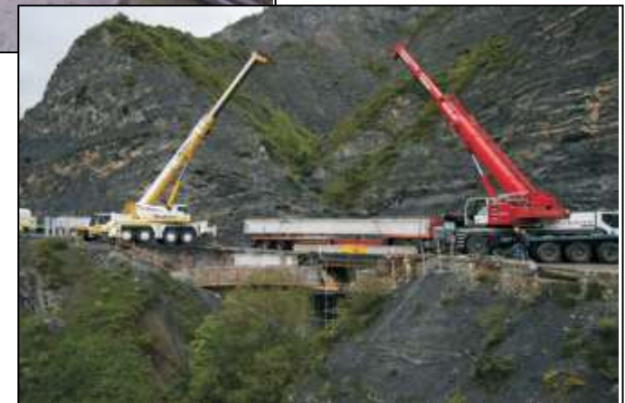
Pont du Seigneur à différentes étapes de sa réalisation
