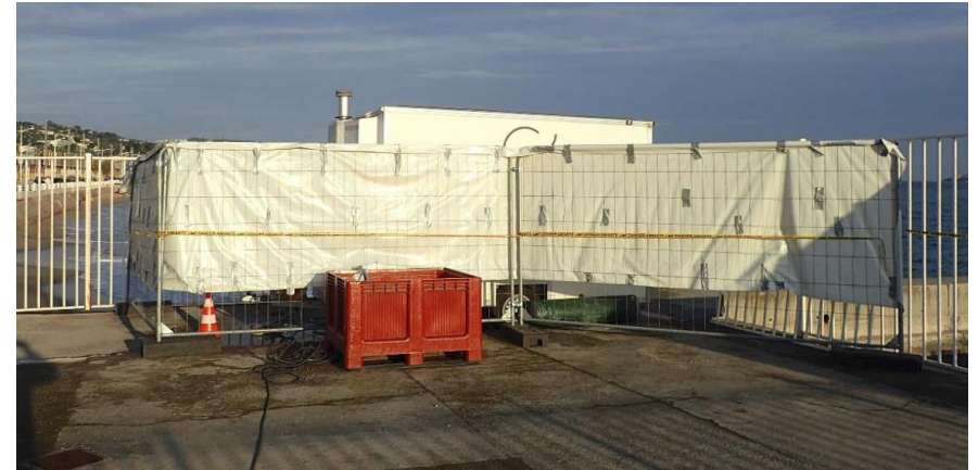
Installations spécifiques pour le désamiantage du ponton de la Darse
