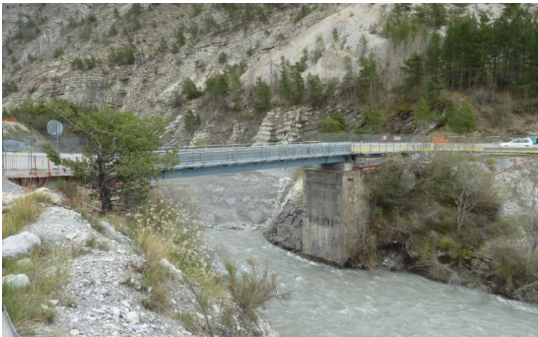
Pont après travaux
