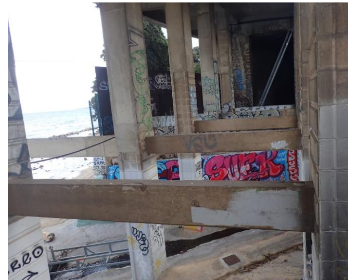
Pont de l'Aube - vue de dessous
