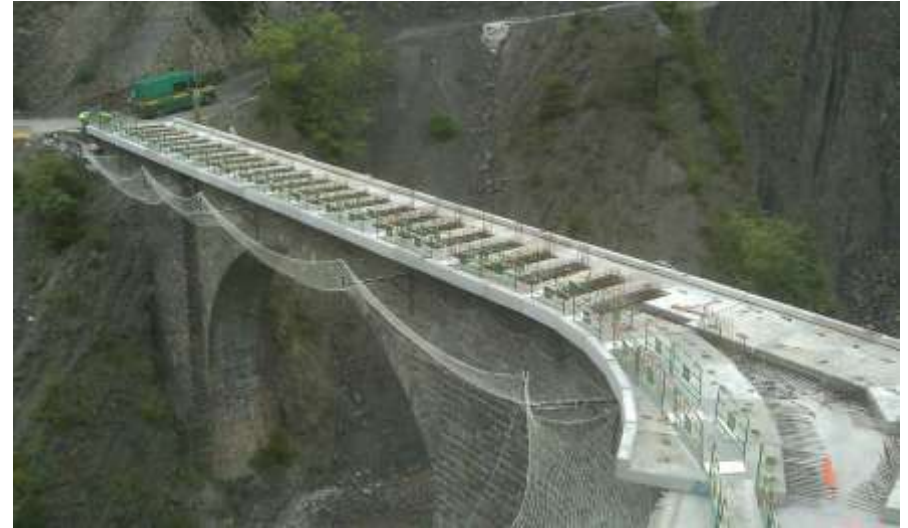
Vue aérienne pendant les travaux
