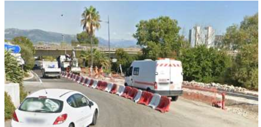
Travaux en cours
