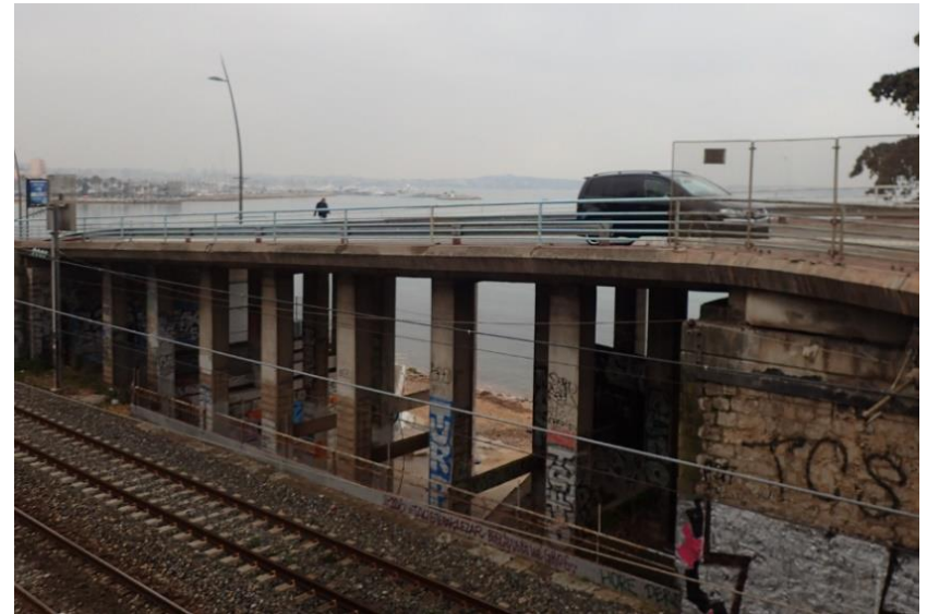
Pont de l'Aube - vue de loin
