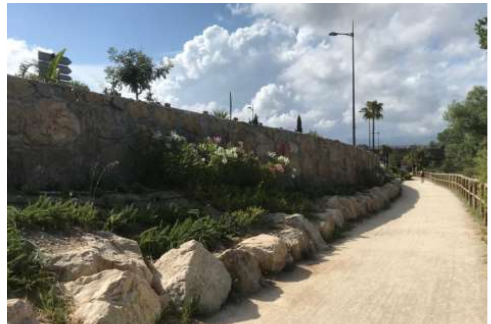
Mur de soutènement en enrochements
