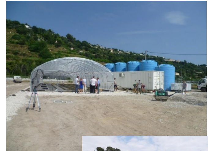
Serre n° 1 Container technique et réservoirs d'eau aériens
