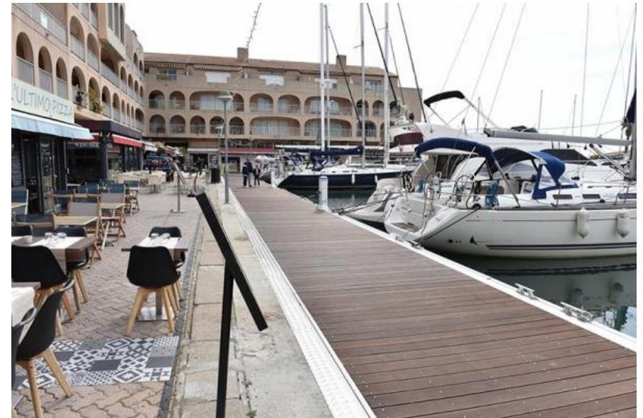
Ponton dédié au cheminement piétonnier
