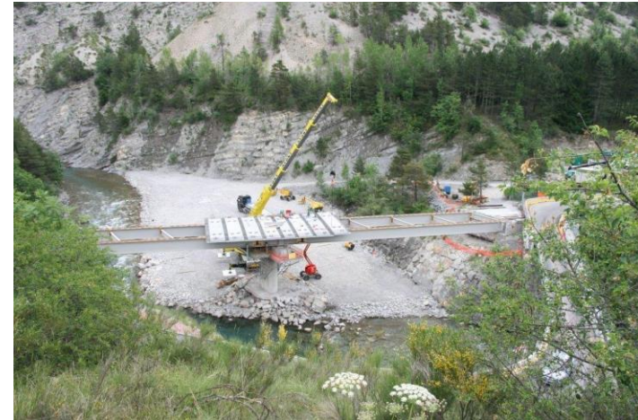
Pose dalles préfabriquées
