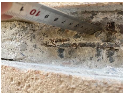
Sondage destructif poteaux d'angle
