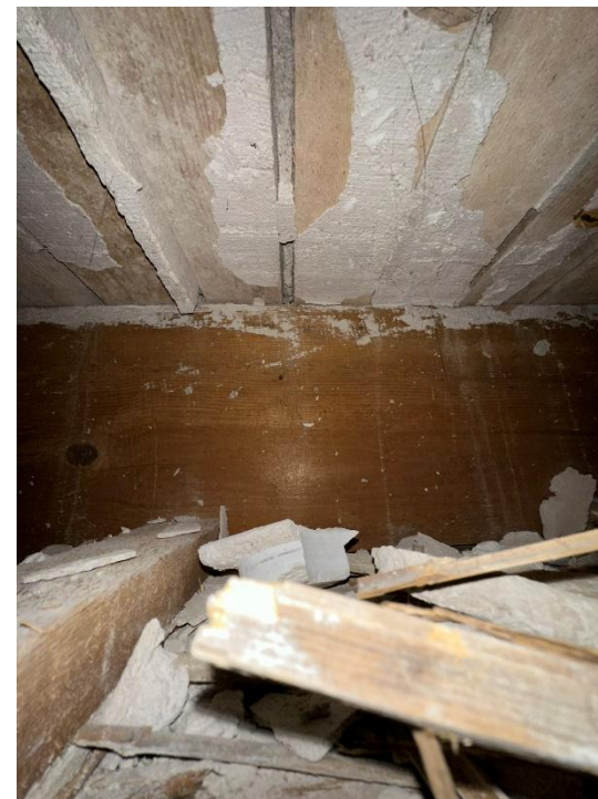
Sondage destructif plancher
