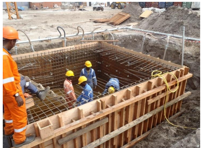
Bassin de récupération des eaux pluviales
