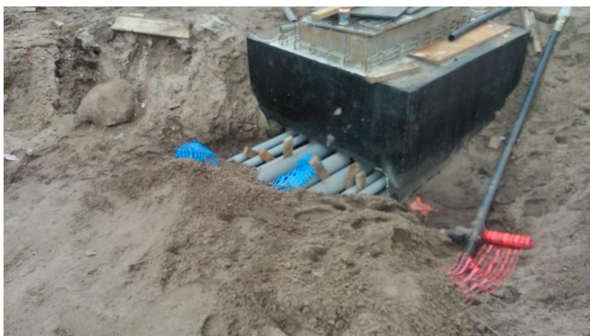
Réseaux secs – fourreaux – pénétration dans regards - calfeutrement
