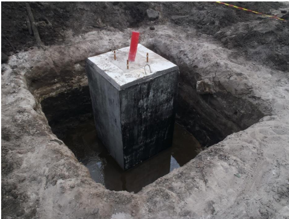
Réseau éclairage – candélabre h=10m – pose massif préfabriqué
