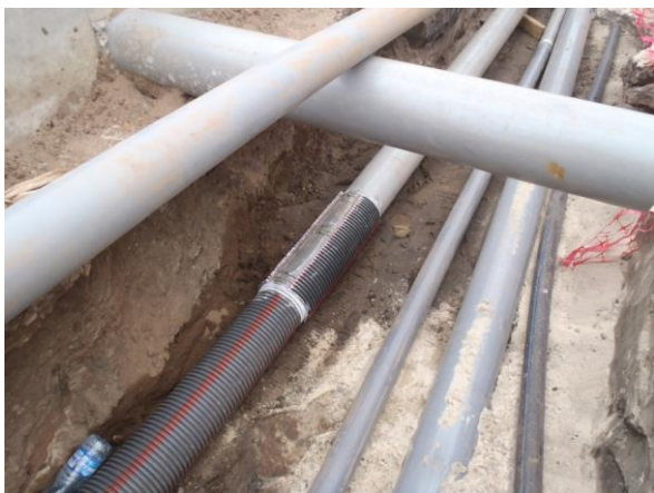
Réseaux secs – croisement réseau existant
