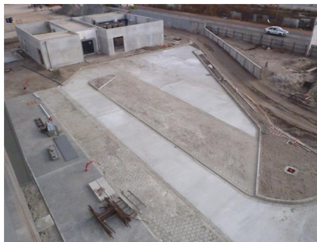
Parkings et voirie Dallage béton fibré et pavage zone ouest
