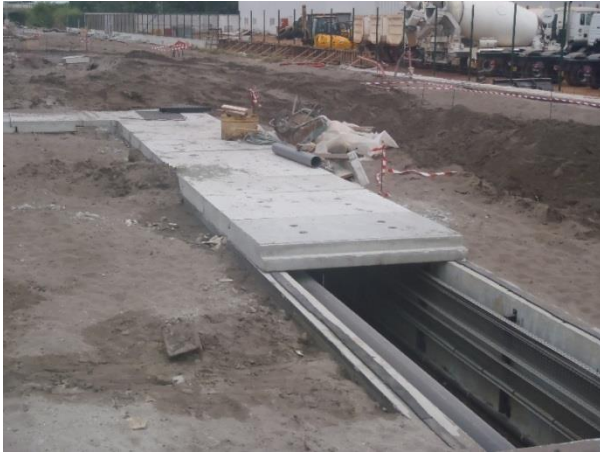
Dalot technique – dalles préfabriquées
