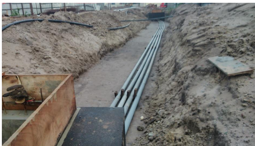
Réseaux secs - fourreaux
