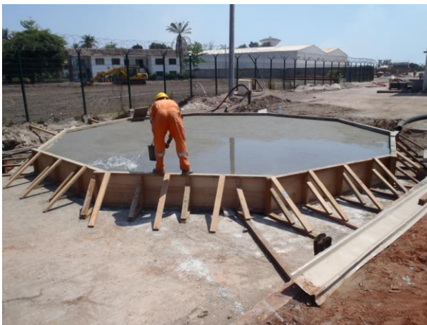
Réseau incendie Dalle sous réserve eau – m.o béton
