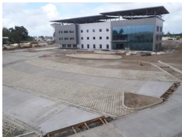
Revêtements – dallage béton fibré et pavage
