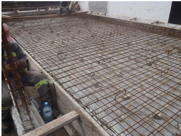
Radier – armatures et coffrages
