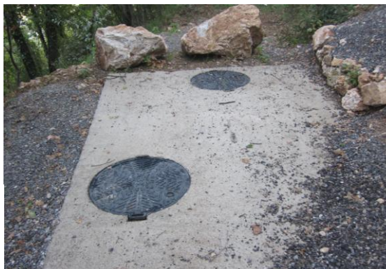
Trappes d'accès du nouveau bassin enterré – ICTP 2013
