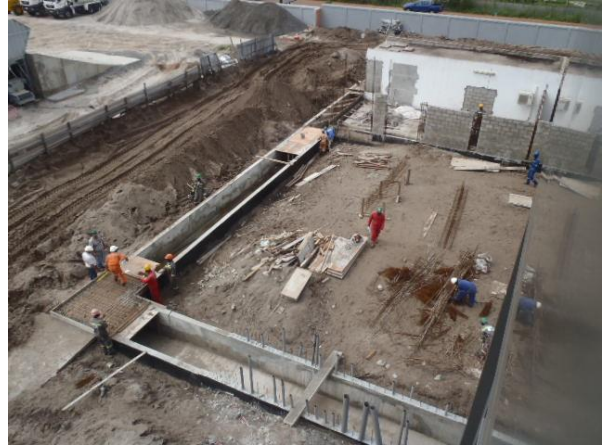
Dalot technique – dalles préfabriquées
