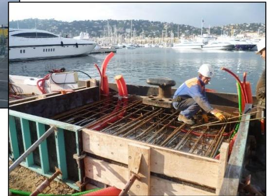
Ferrailage de rehausse des bollards
