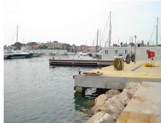
Talus en enrochements surmonté d'une estacade pour former quai d'avitaillement
